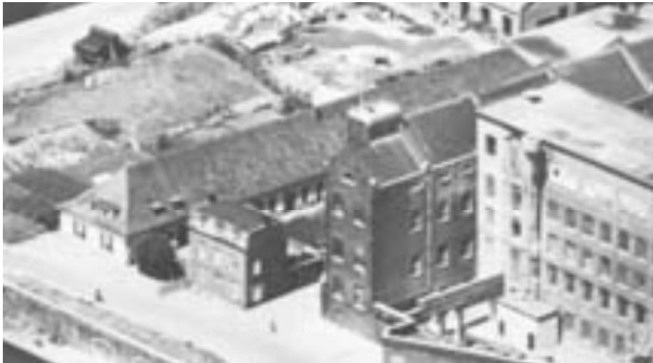
Uitsnede van de loods uit een luchtfoto van 1935 met de oostgevel in het zicht. Afb: RHCL beeldbank, nr. 10548.
