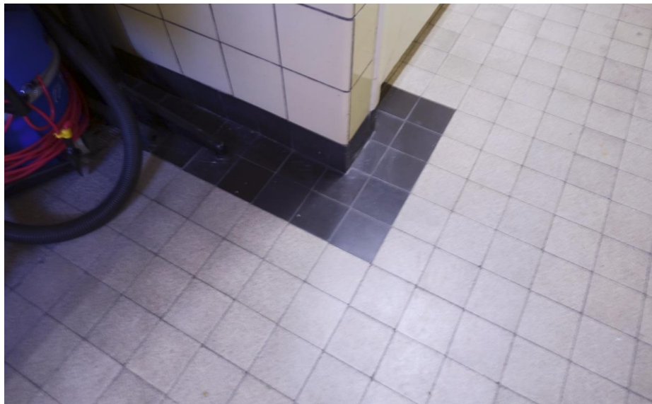
De tegelvloer uit 1940 bij de toiletten.
