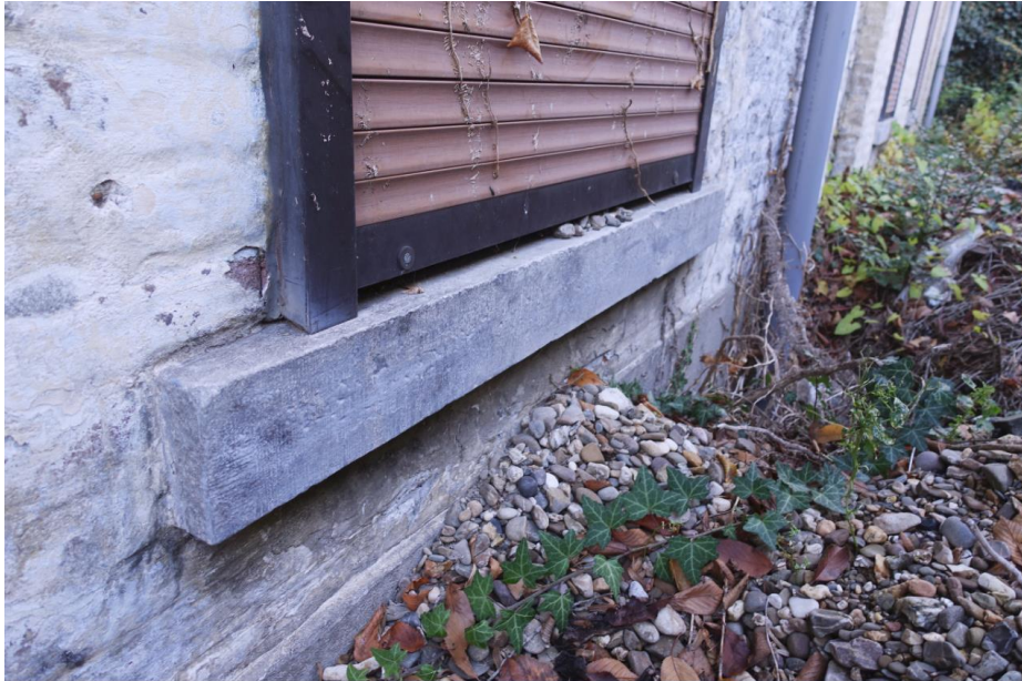
Hardstenen lekdorpel met frijnslag uit 1879-1882 bij een van de vensters in de westgevel.
