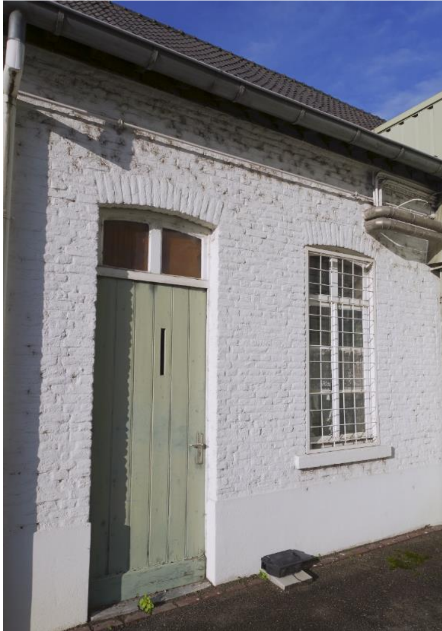
Oude toegang met opgeklampte deur en venster met 6-ruits vulling in de oostgevel.
