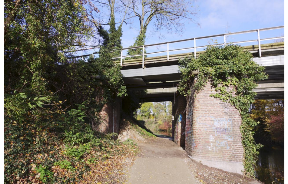
Aan de westzijde is de pijler losstaand van het landhoofd.
