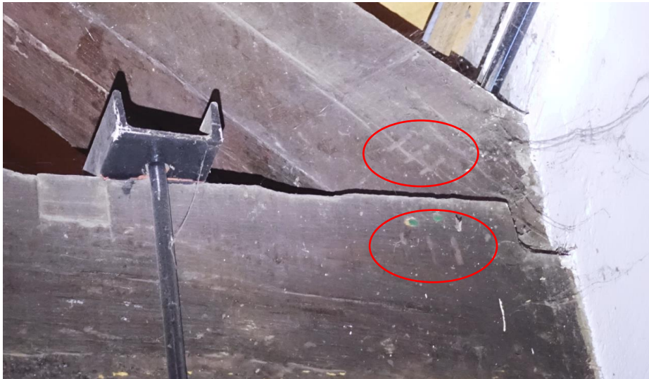
Detail van de westzijde van een juk met op de onderste dekbalk en onderzijde spantbeen een gehakt telmerk in de vorm van drie strepen (III).
