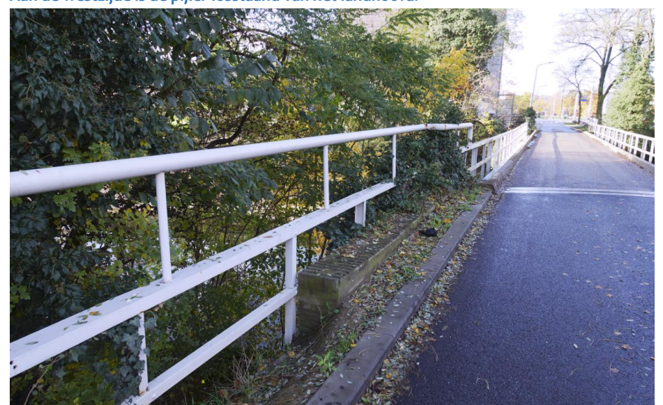
De leuning bij de bovenbouw en het rijdek van de brug stammen uit 1986.
