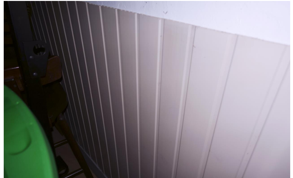
De lambrisering van houten schroten in de ruimte tegen de noordgevel.
