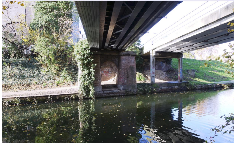
De westelijke pijler, gezien vanaf de oostelijke kade. De bovenbouw is duidelijk minder breed dan de pijler.
