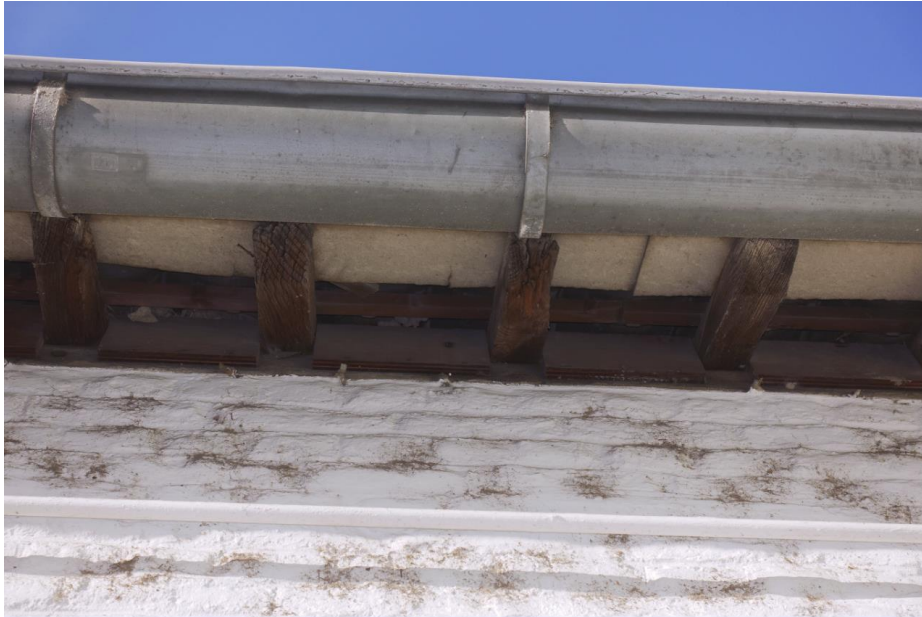
Detail van de bovenzijde van de langsgewels met de klossen en goot uit 1940.
