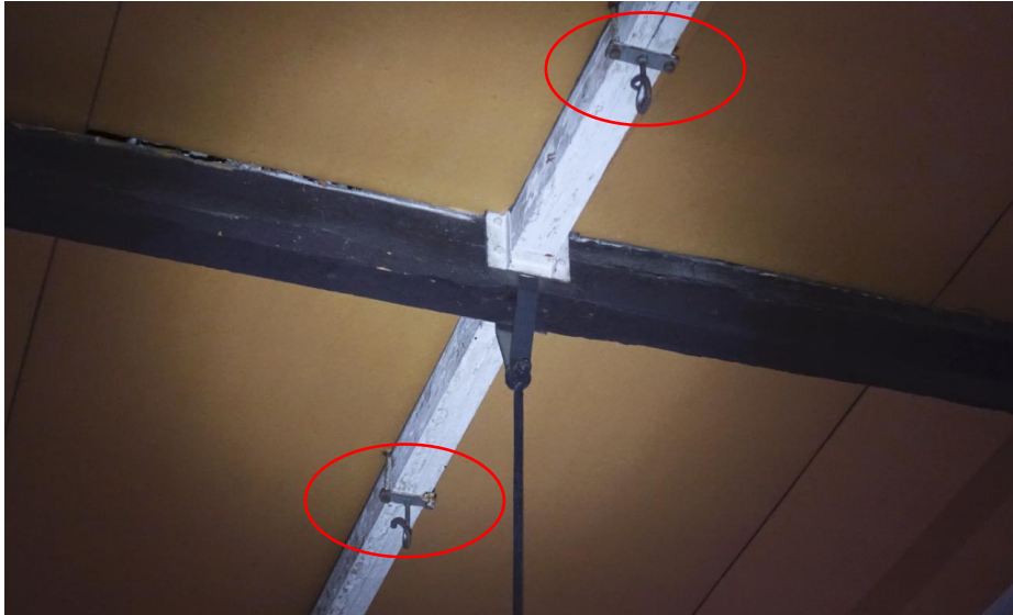
Detail van de bevestiging van de witte balken aan de oude bovenste dekbalken. Deze balken zijn in 1940 aangebracht ter bevestiging van de haken waaraan de gymnastiektoestellen gehangen konden worden.
