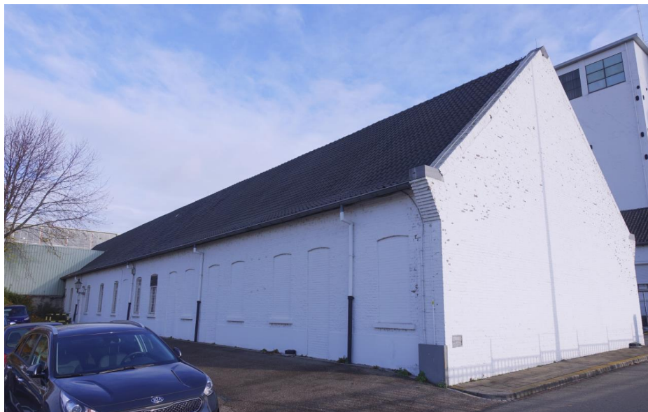
Zicht op de westelijke langsgevel en zuidelijke topgevel van de loods.
