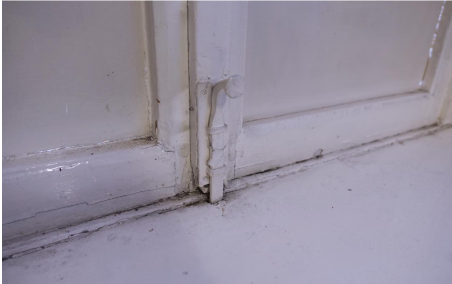
Binnenzijde van de draairamen met een detail van de sluiting aan de onderzijde.
