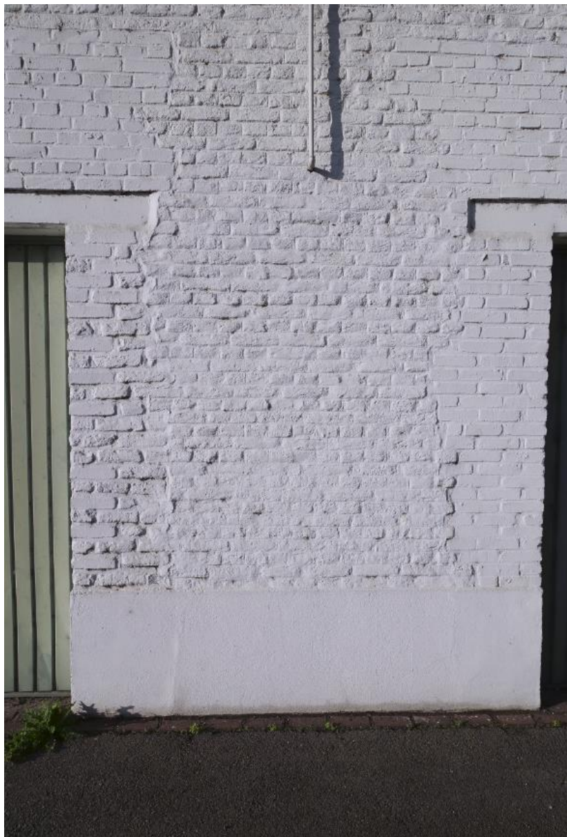
De oostgevel in detail, met bij de dagkanten en boven de openingen nieuw metselwerk.
