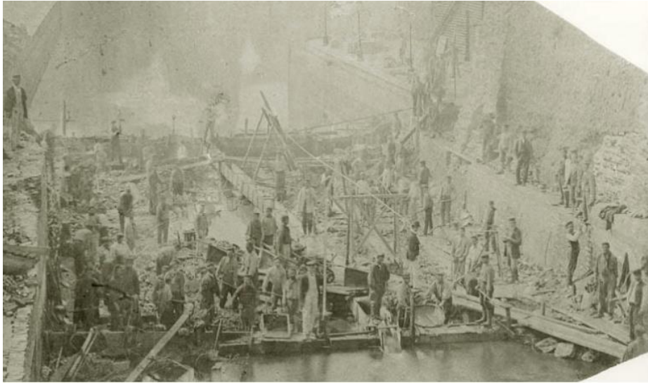
Verbreding van de verbinding tussen de Zuid Willemsvaart en het Bassin in 1865-1870. Later zou over deze verbinding de twee bruggen in de Fransensingel worden aangelegd. RHCL beeldbank, nr. 10507.
