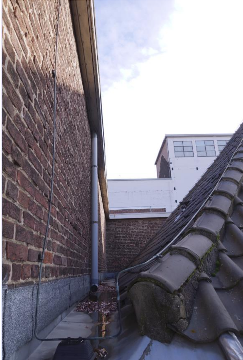
Zicht op de aansluiting met de jongere bebouwing aan de noordzijde van de loods.
