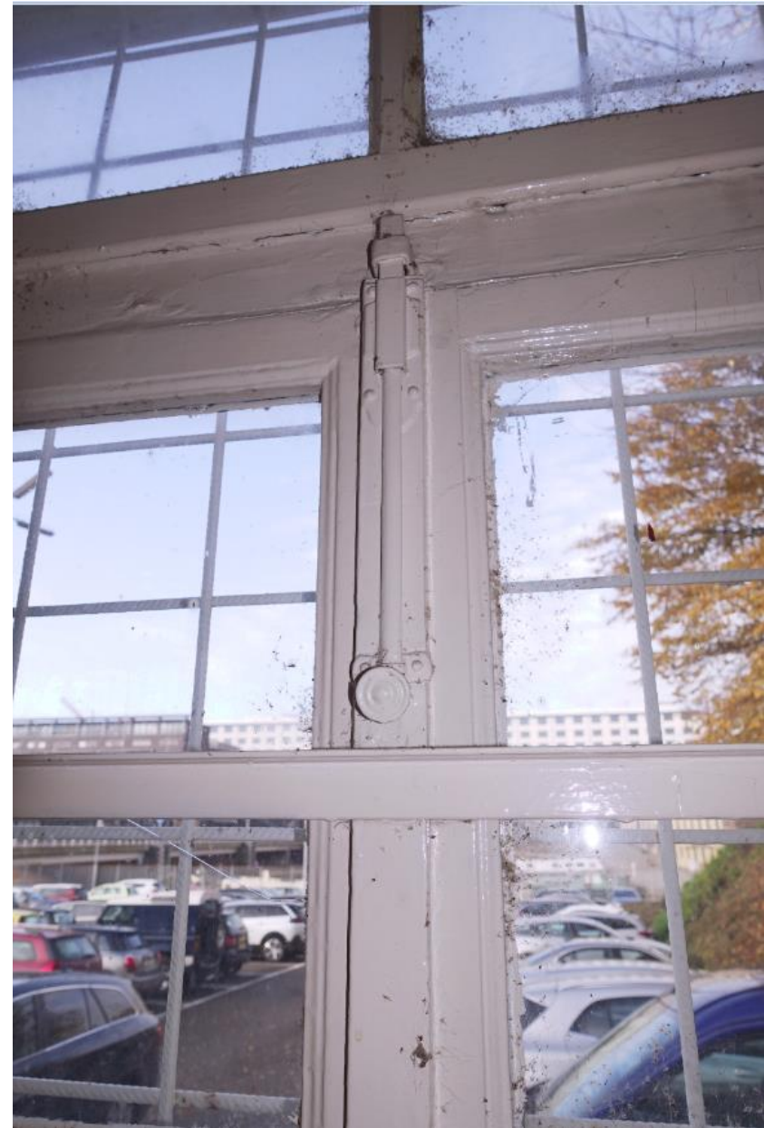
Binnenzijde van de draairamen met een detail van de sluiting aan de bovenzijde.
