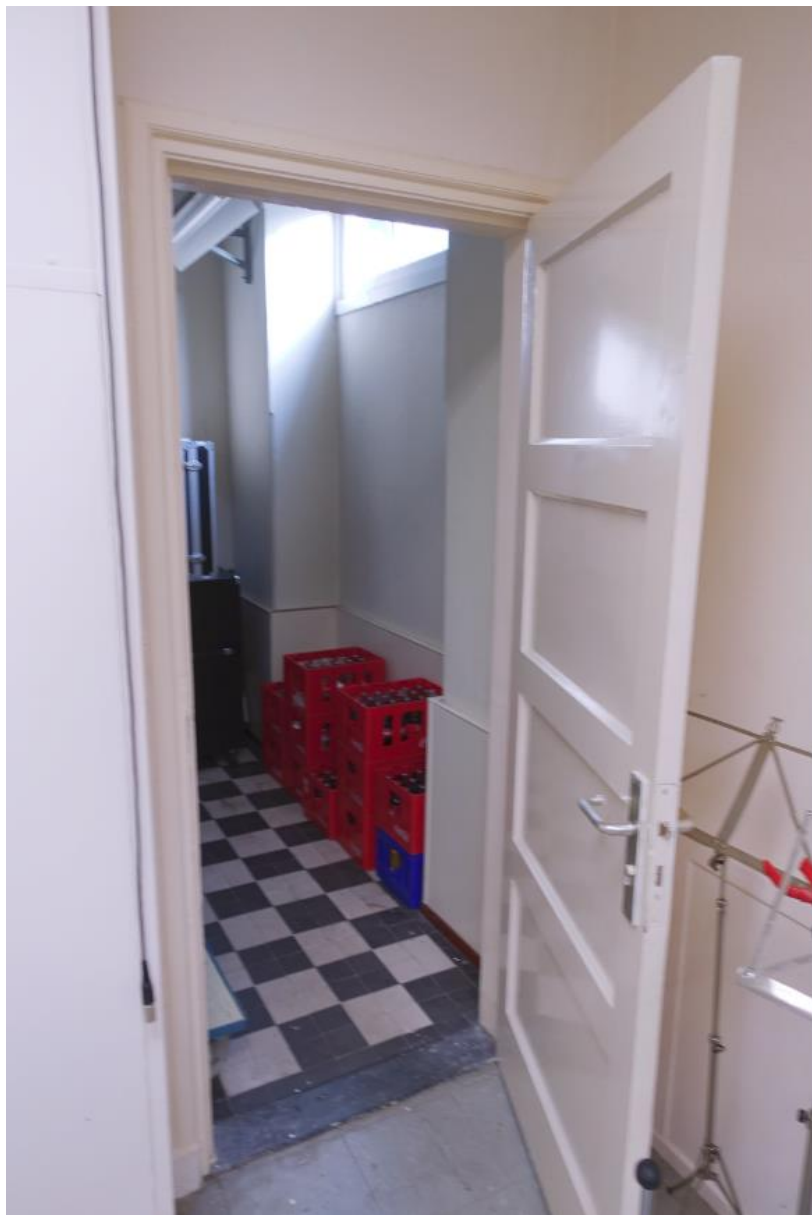
Een oude Bruynzeeldeur uit 1940 in de doorgang tussen repetitieruimte en vestibule tegen de oostgevel.
