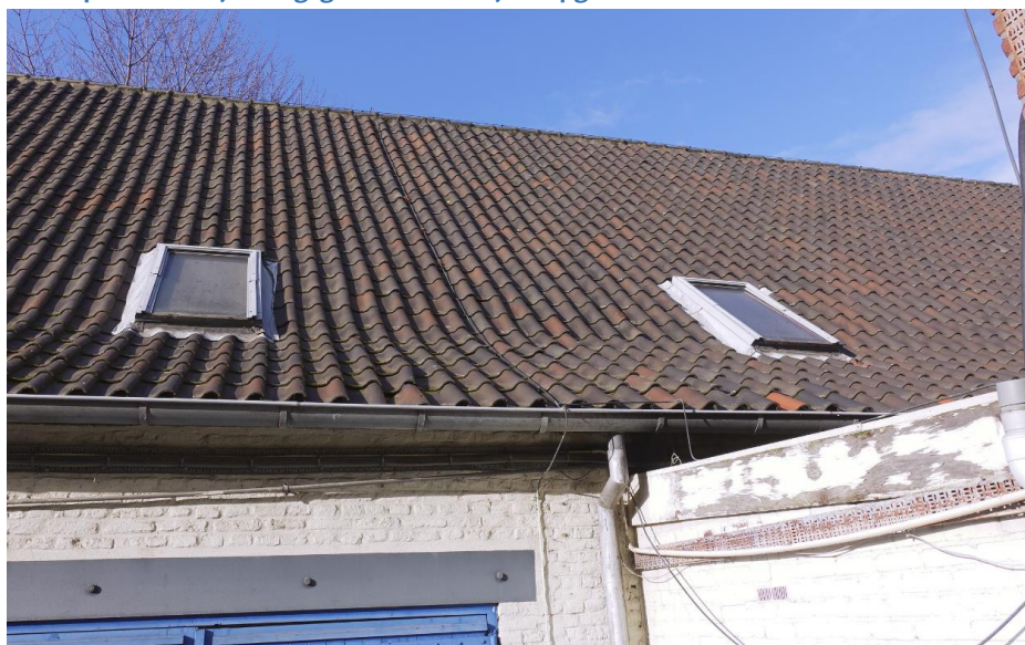
Zicht op de dakbedekking van romaanse pannen en dakvensters in het oostelijke dakvlak van na 1940.
