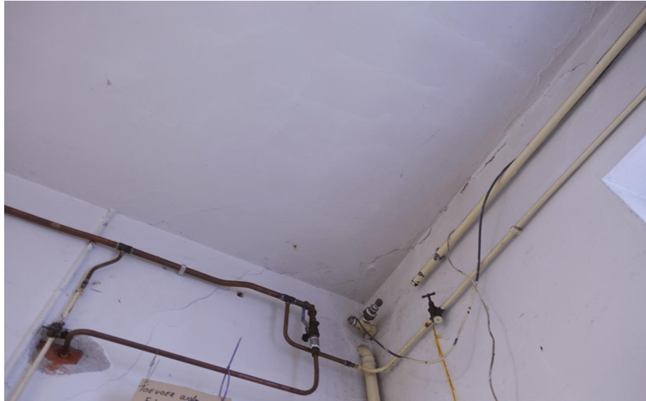
Een ouder stucplafond, mogelijk stammend uit 1940, aangetroffen boven de toiletruimte.
