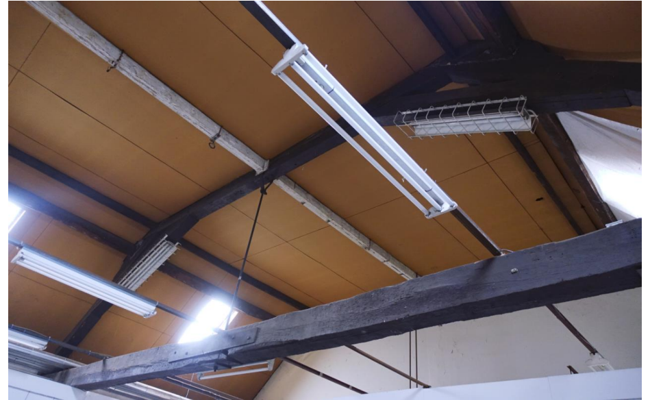
Zicht op een van de spanten uit 1827 boven de loods.
