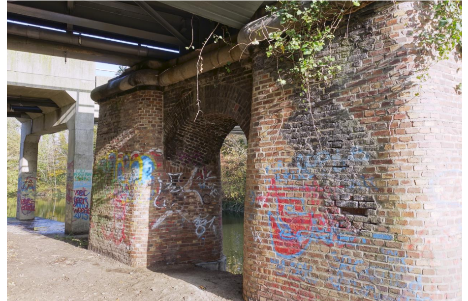
Zicht op de achterzijde van de westelijke pijler met tussenliggende boog in het midden.
