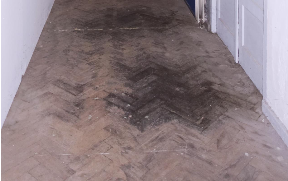
In de ruimte waar het schildersatelier is gesitueerd is een mogelijke oudere parketvloer in visgraatpatroon aanwezig.
