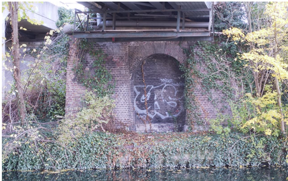
De oostelijke pijler, gezien vanaf de westelijke kade.
