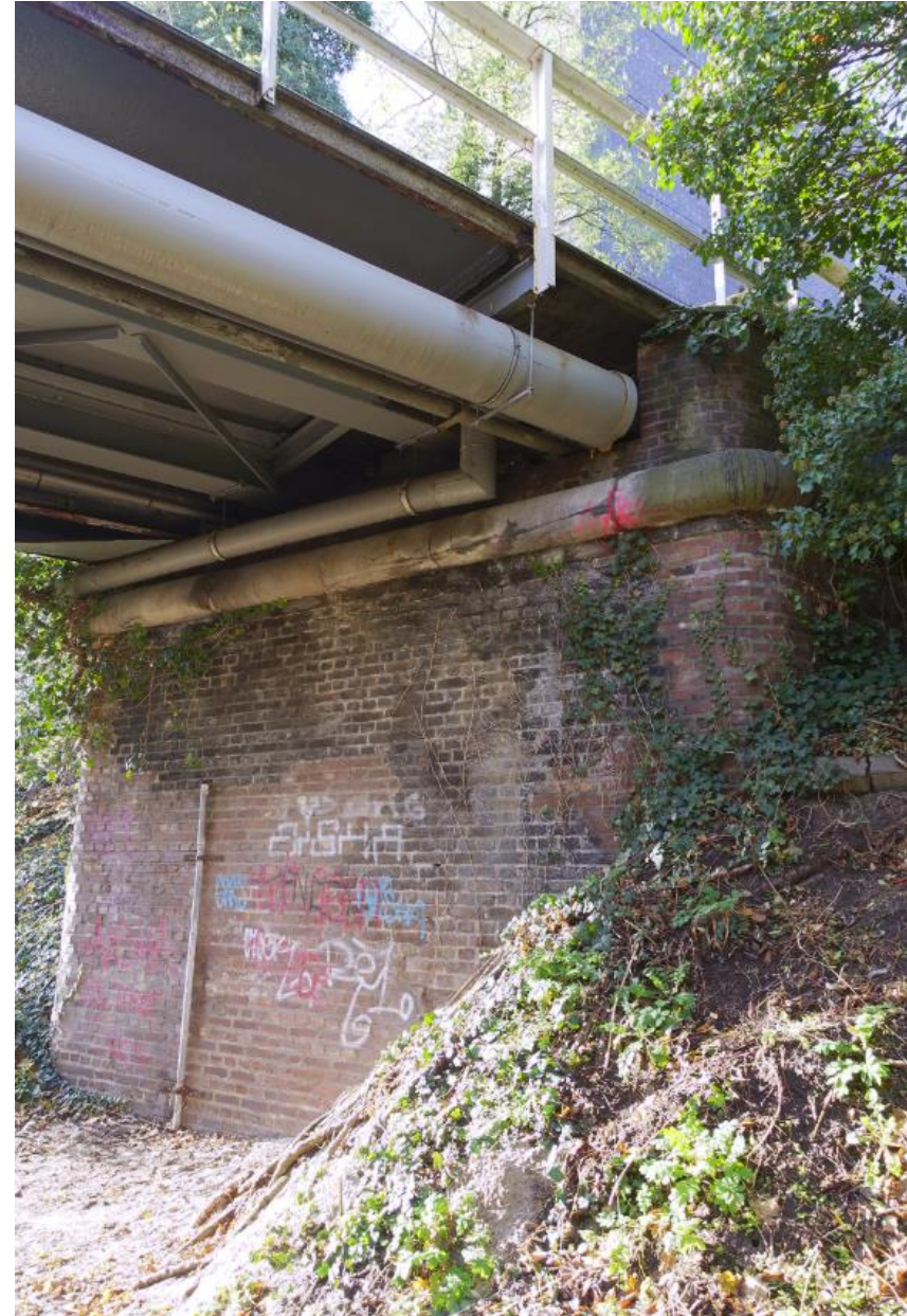
Het westelijke landhoofd aan de waterzijde.
